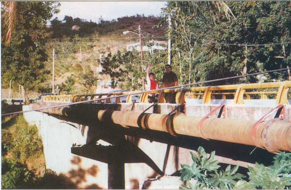
La nave estaba situada encima del puente.
