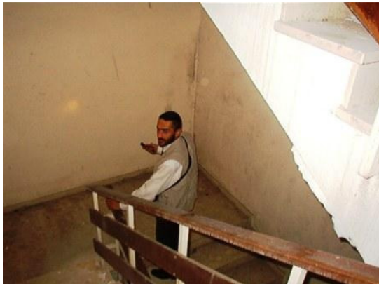
Escalera entre la tercera y cuarta planta
