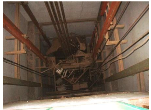
Estado de los ascensores
