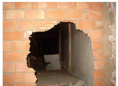
Uno de los pasillos tapiados
