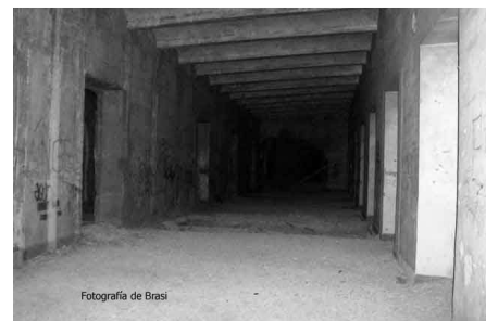
El pasillo de la parte superior.
