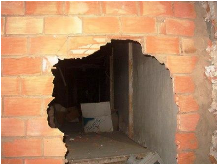
Uno de los pasillo tapiados
