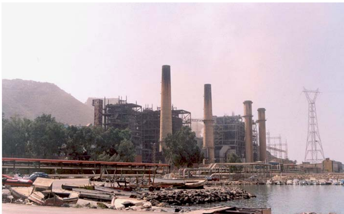
Central térmica, en el complejo industrial de Escombreras. Agradecimiento a www.cartagena.es/frontend/pagina/_xzuM2Hlr2V8
